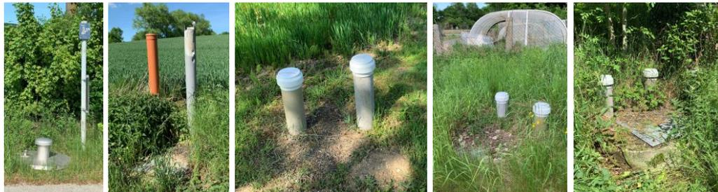
Abbildung 5-7: Entlüftungsstationen der Abwasserdruckleitung in Fließrichtung
