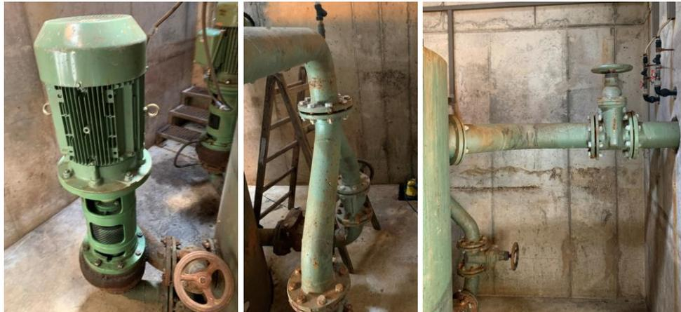
Abbildung 5-5: Abwasserhebeanlage Strate Awalift 3/2
